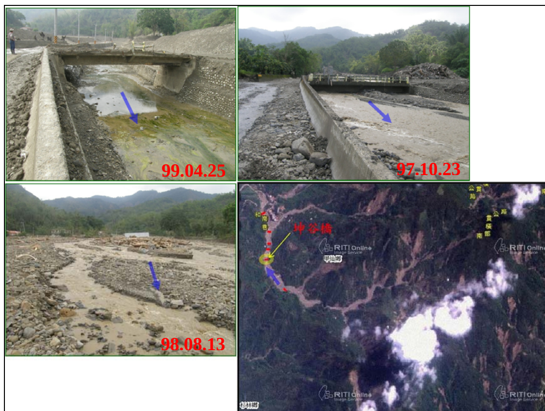
圖 6-10 集水區踏勘-坤谷橋
