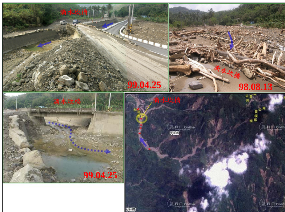
圖 6-5 集水區踏勘-滴水坎橋
