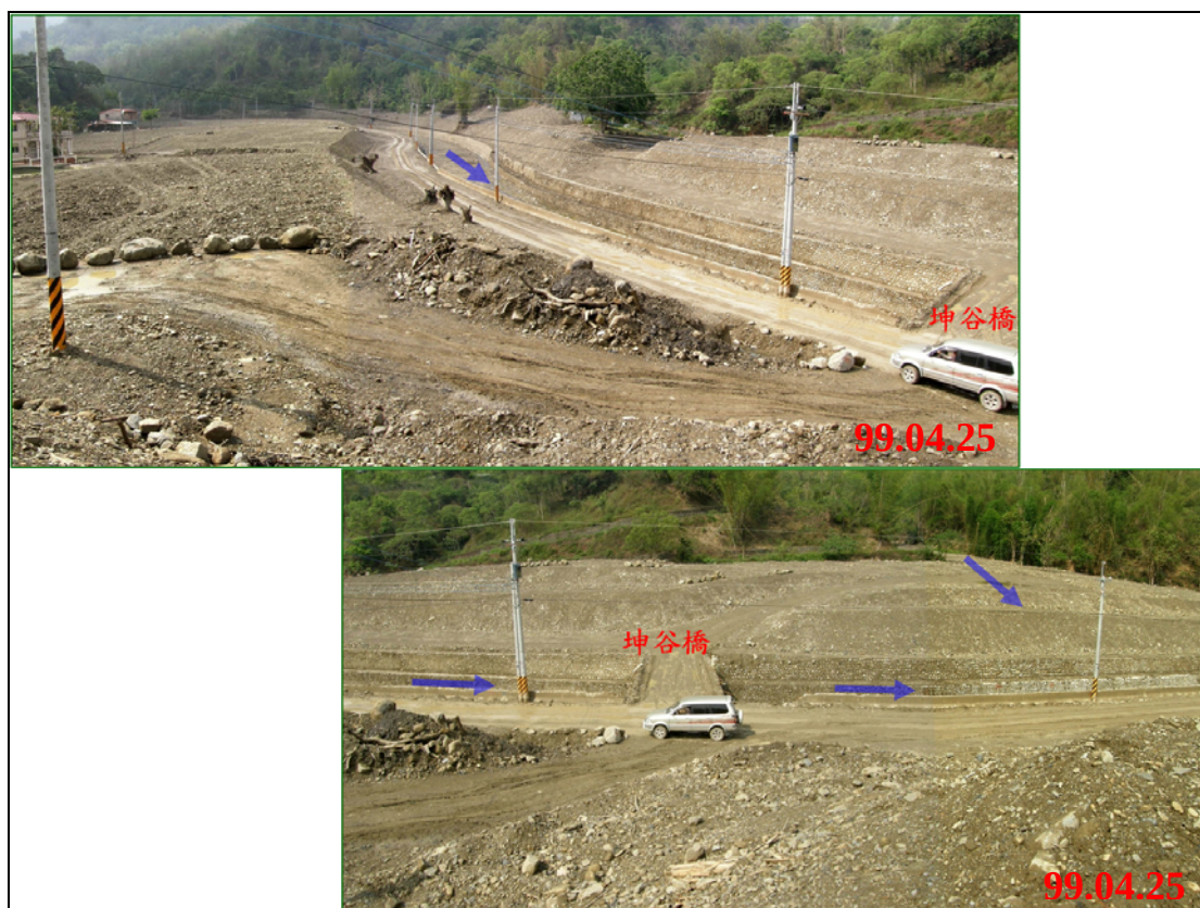
圖 6-11 集水區踏勘-坤谷橋 2
