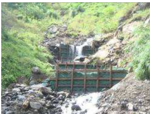
道路上邊坡蝕溝控制
