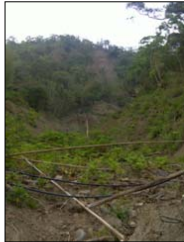
支流4(珍藍橋)崩-8
