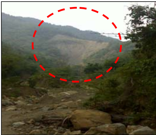
支流3(內英橋)崩-1
