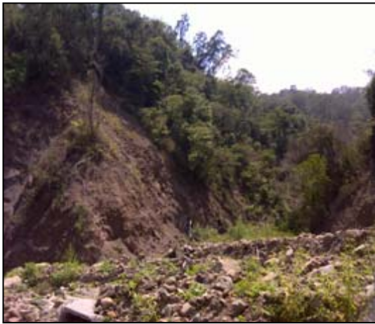
支流4(珍藍橋)崩-13
