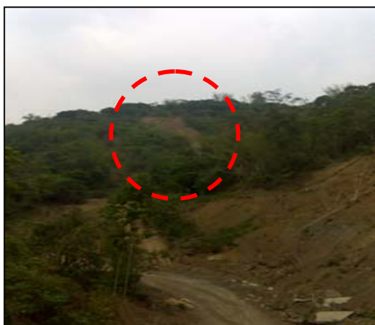
支流1(上智橋)崩-11
