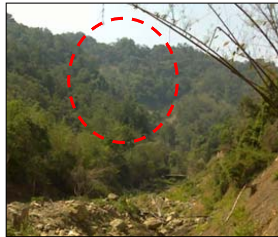
支流4(珍藍橋)崩-18
