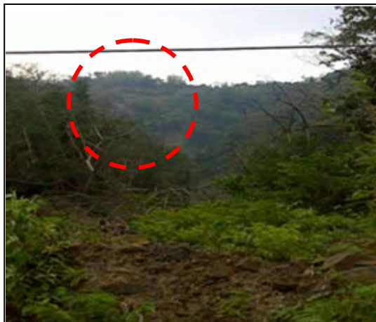
支流1(上智橋)崩-6
