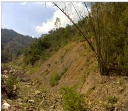
支流4(珍藍橋)崩-28
