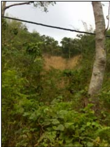
支流3(內英橋)崩-11
