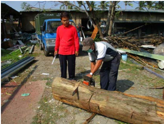
圖 67. 田老闆以鏈鋸將腐朽嚴重之基部鋸除
