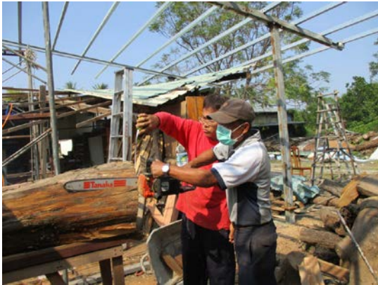
圖 75. 田老闆及木工師傅以鏈鋸鋸除根張處
