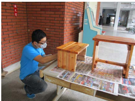
圖 99. 以二度底漆油漆台灣杉製作之矮板凳
