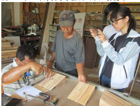
圖 61. 木工師傅以釘槍補強底座部分
