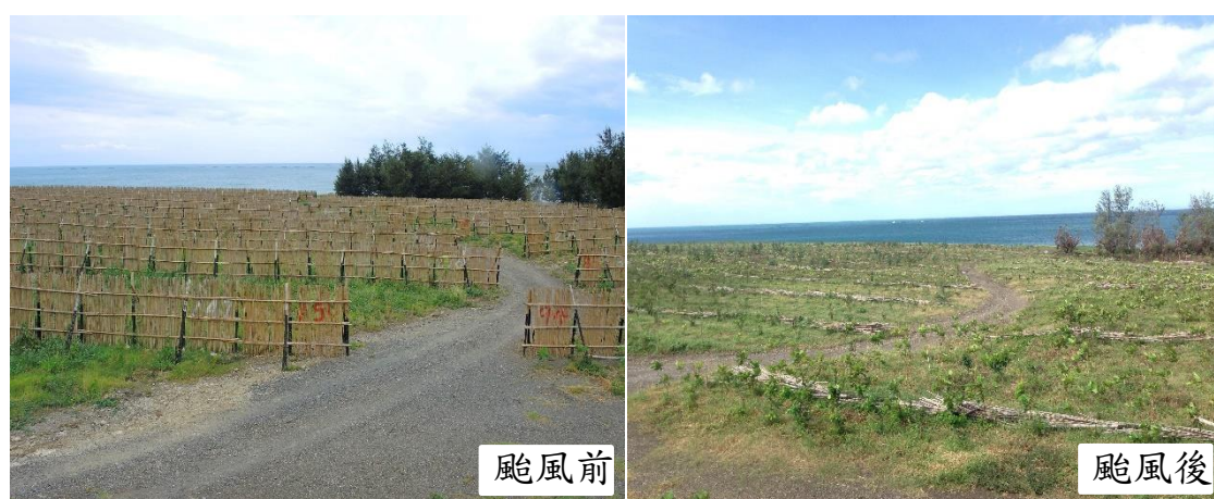
圖 3-3 海岸全面整地復育造林區受颱風侵襲前後防風籬損壞狀況
