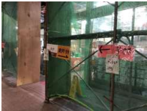
▲三冠王芋冰城雖進行外牆施工，仍熱情將海報公告在施工鷹架上
