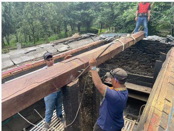
圖 17 更換傳統領袖家屋屋頂中樑
