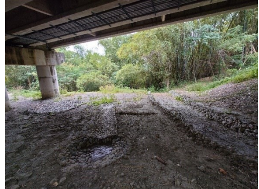
(8) 馬頭山二號橋橋下通道 U 型溝、生態池於 2022 年 8 月完工，但地被裸露，覆蓋度低
