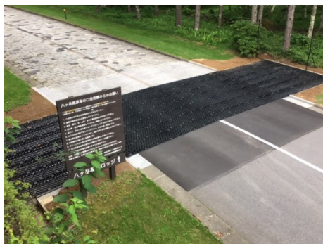
圖 28、日本發展的六角形防鹿踏板及超音波蜂鳴干擾器已有良好的使用經驗，可以引入運用在台 28 線馬頭山路段，來防止鹿類動物入侵路面，導引牠們使用路面下生態通道。
