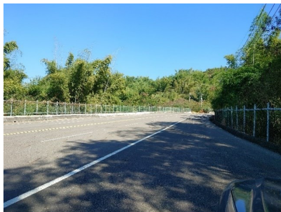
(2) 馬頭山一、二號橋路段防護圍籬，具防止丟棄廢棄物及動物導引防護功能
