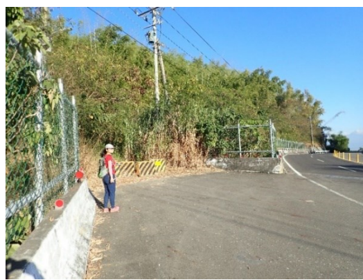
(4) 防護圍籬缺口目前僅以高約 85cm 的紐澤西護欄阻隔，鹿類動物可以輕鬆跳過，可能形成圍籬缺口效應
