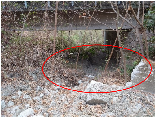
(9) 馬頭山一號橋省道舊路護欄拆除約 2m 及修築緩坡形成動物通道
