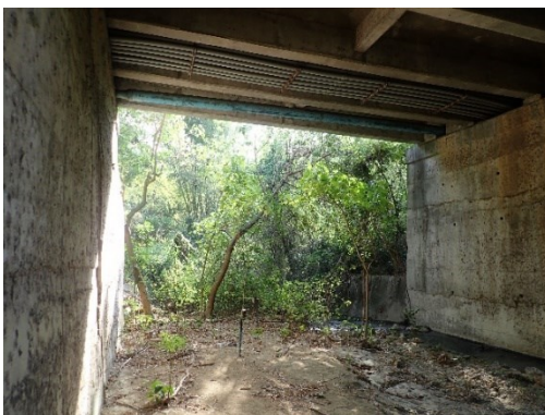
(11) 鹿天橋橋下通道腹地較小，已完成南側溪岸護坡以土石包堆疊修坡，增加動物利用
