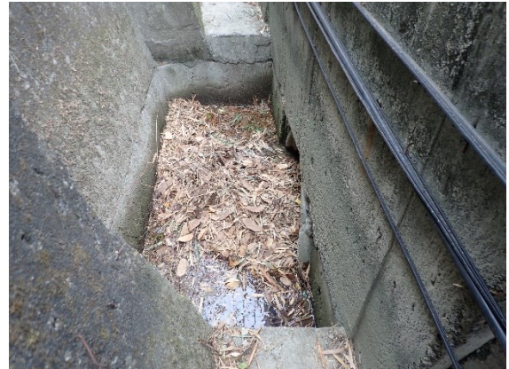
(6) 23.4K 箱涵 2 西向北側出口小型集水井，建議設置逃生坡道，可為食肉目、龜鱉類等動物通道。
