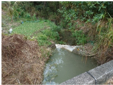
(15)26.7K 淵源橋東向南側上游經登月橋下承接天然溪溝，溪水尚稱乾淨，南側西岸有私人梯田，為潛在鹿科動物通道。但因護坡過於陡峭，需進行坡度減緩改善，方可利用。
