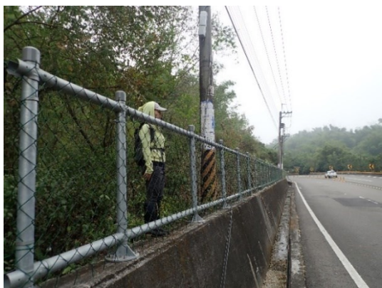
(3) 23.4K 矮駁坎上方圍籬高 135cm，距離路面高約 260cm，鹿類動物仍有機會跳躍侵入路面。南區養護工程分局於 2023 年 10 月已在圍籬後方補植密灌叢進行改善。
