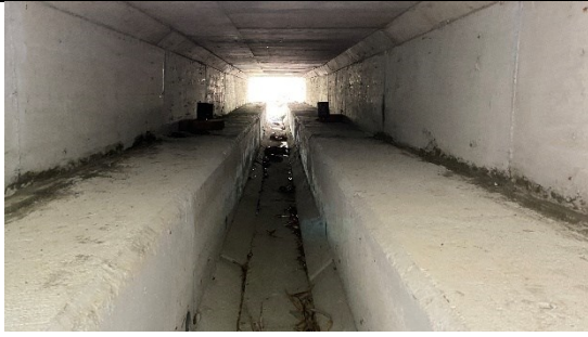
(13)26.5K 箱涵改善建議-箱涵內墊高動物平台通道示意圖。照片來源:農業部生物多樣性研究所野生動物組林德恩副研究員提供。
