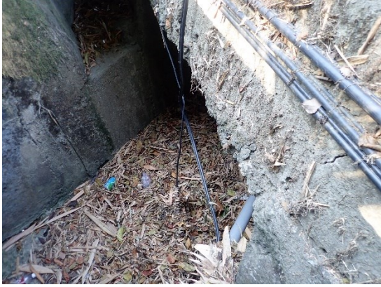
(1) 位在 21K 附近的箱涵 1 東向南側入口，與現有溝渠落差約 90cm，建議增加爬坡逃生坡道，可做為食肉目及龜鱉類通道。
