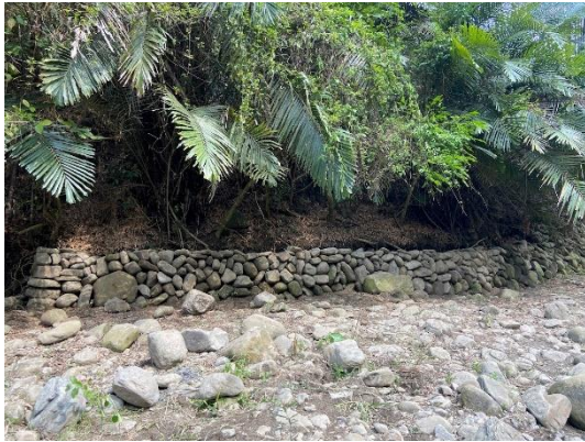
圖 5.5-8：「河溪治理的億種行動工作坊」以 手作完成的砌石護岸
