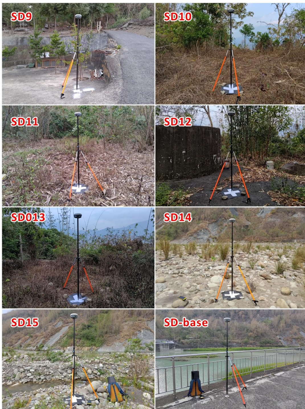
圖 4-6 於 4 月 7 日至 8 日進行第一次空標點測量作業。
