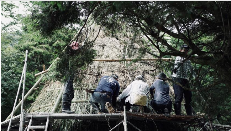
圖 26 穀倉屋頂修建
