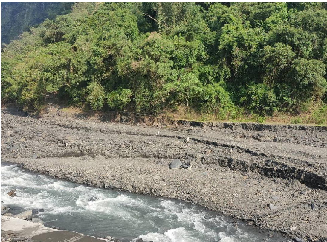
圖二十三、2024 年 7 月凱米颱風造成河岸旁的補植區域全數坍塌。
