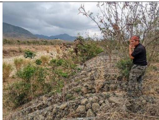
C-17_保力溪溪壩橋上游向右岸原有的石籠
