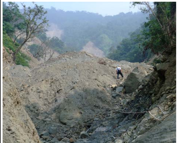
里程 1K+000 崩塌堆積現況 (98.10.21)
