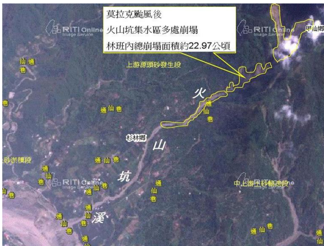
圖 3-2 火山坑集水區林班地崩塌災害區位衛星影像圖（莫拉克颱風後）
