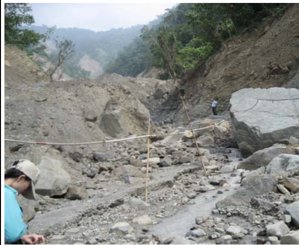
里程 0K+983 上游崩塌堆積現況 (98.10.21)
