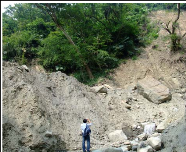
里程 1K+200 崩塌堆積現況 (98.10.21)
