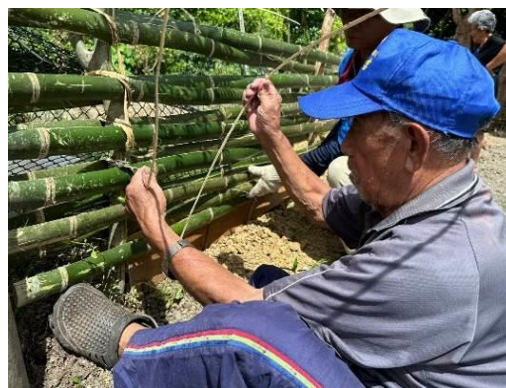
福桂耆老教部落青年利用在地竹材編織圍籬，並取黃藤來綁竹籬。
