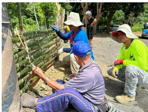
福桂耆老教部落青年利用在地竹材編織圍籬，並取黃藤來綁竹籬。
